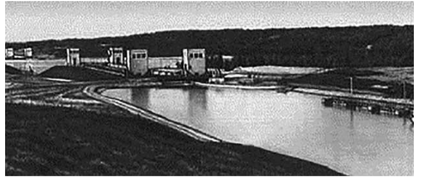
Шлюзы Волго-Балтийского канала
